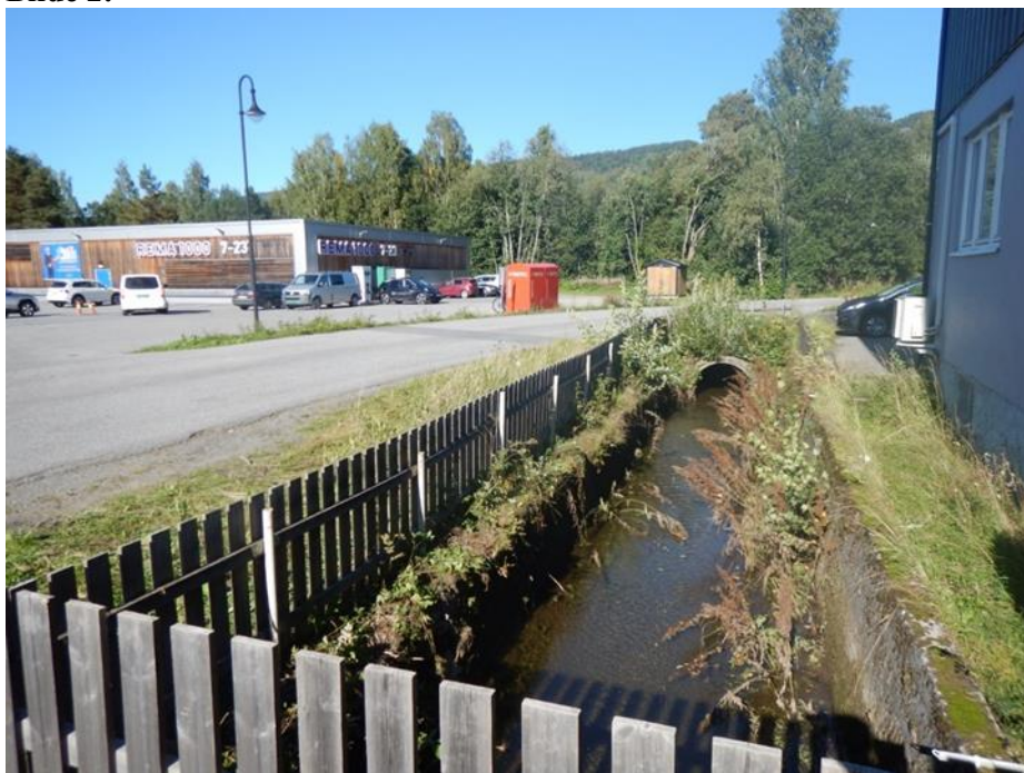
Kvernsvebekken gjennom Dokka sentrum. Gikk over sine bredder under Hans i Dokka sentrum.
